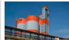
Евроцемент БАЛАКЛЕЙСКИЙ ЗАВОД
